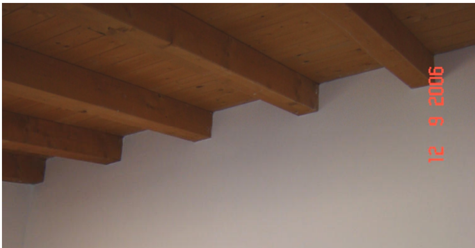
Figura 1 – vista della parete con sovrastante copertura lignea
