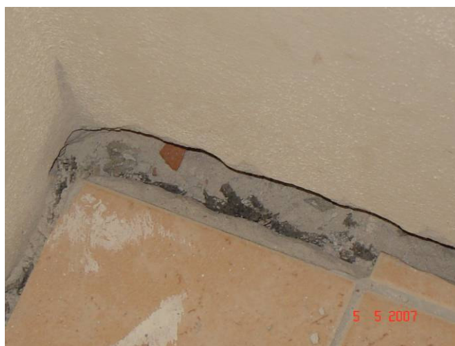
Figura 2 – Eliminazione di una connessione rigida perimetrale (lunghezza cm 15 circa)
